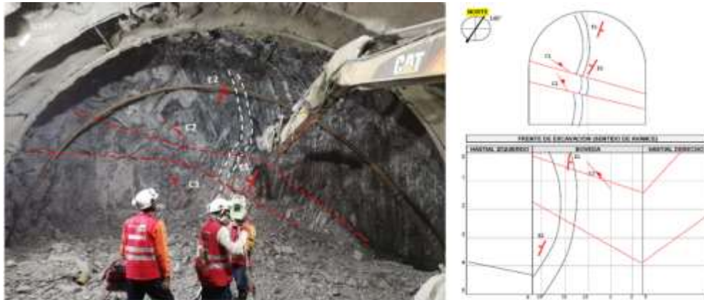
Ilustración 10.11. Avance PK 35+810,25. Sección ST-IV, Tomado y modificado a partir de: CAM, (2019).
