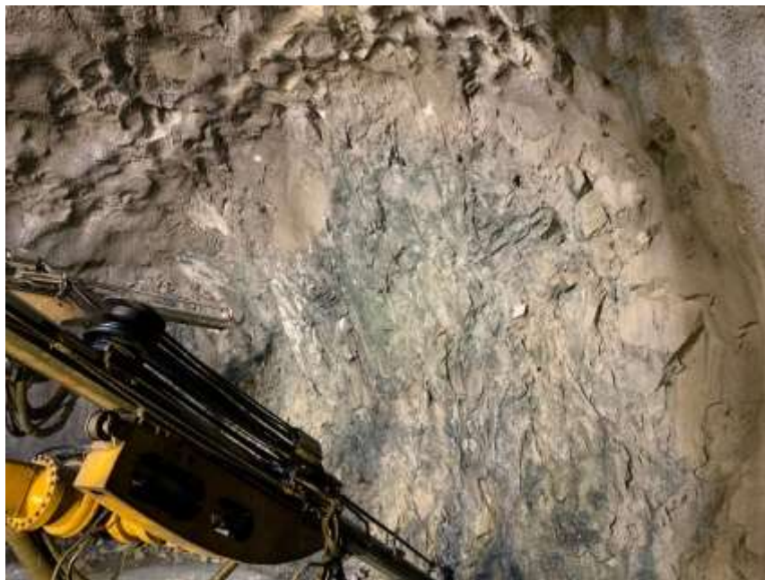
Ilustración 10.8. Basaltos verdes de la formación barroso en los frentes de excavación del portal entrada (Giraldo). Fotografía tomada en el tubo principal.
