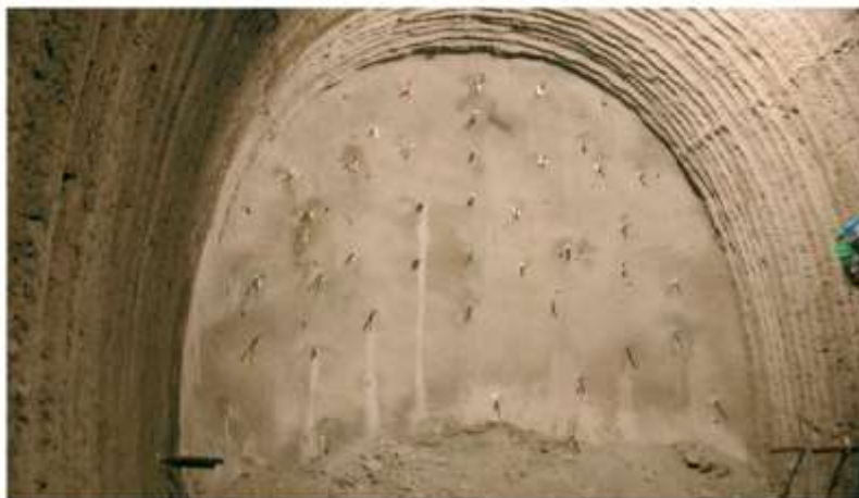
Ilustración 21.4. Sellado pernos de fibra de vidrio. Foto de ejemplo en otro proyecto en Italia.
