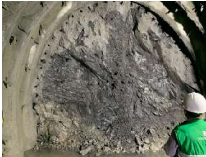
Ilustración 10.9. Lutitas negras con venillas de cuarzo en estratos pinchados de basaltos verdes a negros. Fotografía tomada en la galería de emergencia del portal salida (Cañasgordas).
