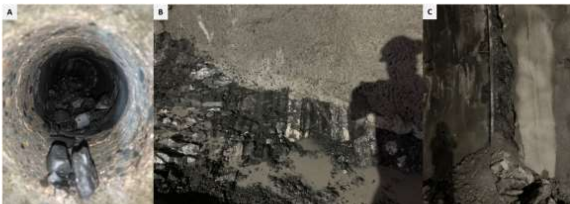
Ilustración 16.2. Zonas donde se recolectaron las muestras en el tramo objeto de estudio. A) Agujero perforado para extracción de roca. B) Hastiales descubiertos. C) Zonas de saneo posterior a la instalación del soporte como acción de reparación.
