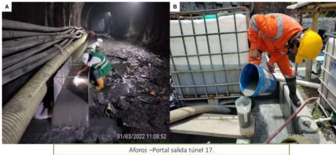
Ilustración 18.1. Aforos de caudales portal salida túnel 17 GGE. A) Aforo al interior del túnel. B) Aforo en la salida del túnel. Tomado de: Consorcio al mar, (2022).
