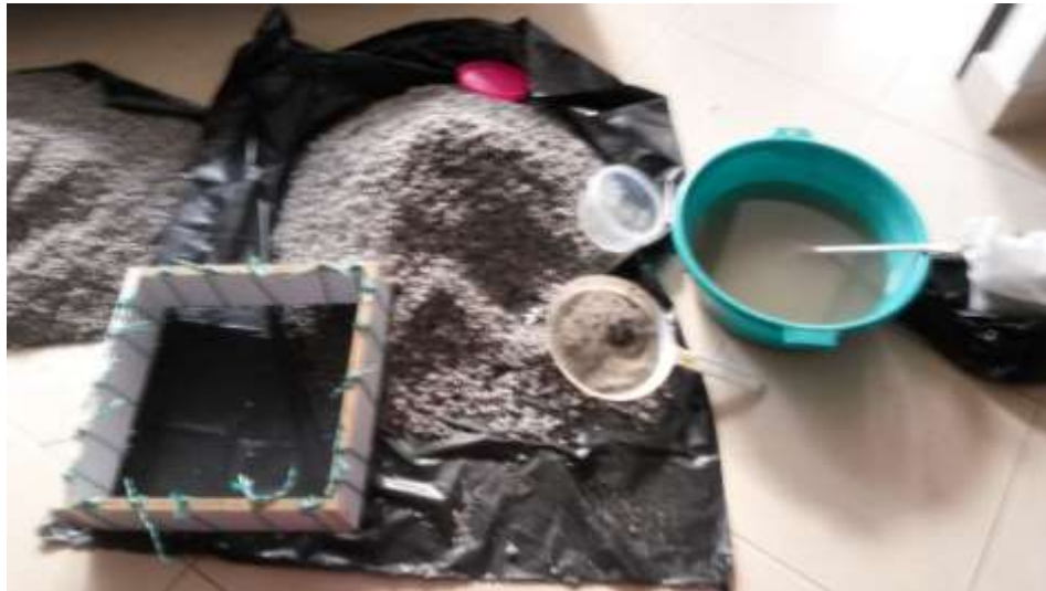
Figura 4. Recubrimiento manual con lechada de cemento
