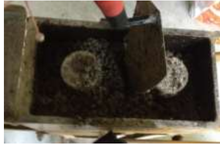
Figura 8. Vaciado de Bloques
