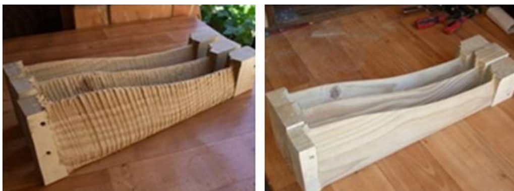
Figura 6. Construcción de un aerogenerador en madera (Anyi & Kirke, 2011)
