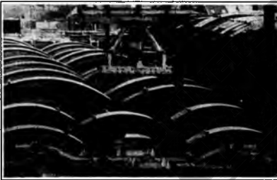
Los arcos de concreto que forman las paredes del Túnel. De la revista Time.
