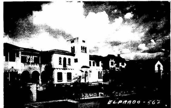
En ANDRÉS FARJAS JARAMILLO OLANO. Y la casa de la torre blanca fue la vivienda de Don Ricardo, en Balboa con Belalcazar.
