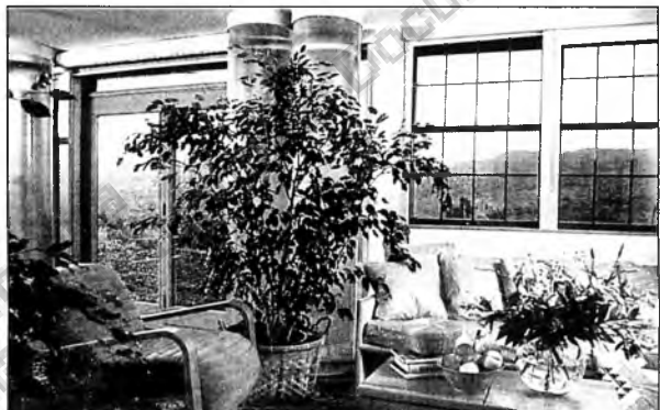
En el día, el sol que atraviesa las ventanas calienta el agua de los cilindros (espacios de columnas grises, de un material plástico). En la noche éstos se encargan de liberar el calor almacenado. Es el interior de una casa en las alturas de Alburquerque, Nuevo México.
