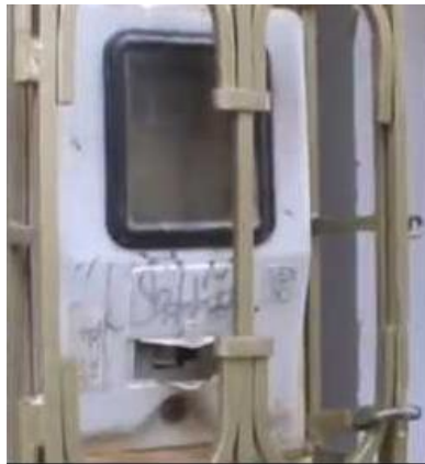
Figura 2. Caja Metálica para alojamiento de medidores eléctricos.
