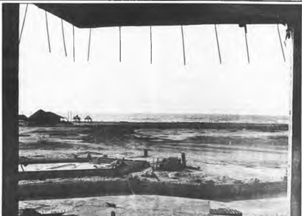
Toda la infraestructura Bocaranoa será una gran ciudad dotada de centros comerciales, puesto de salud, iglesia, modernas avenidas, discoteca, agua potable y luz, propias del proyecto.
