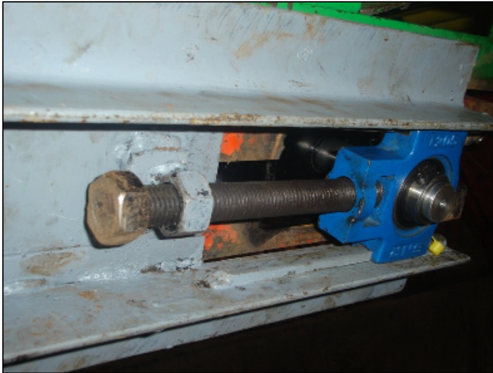
Figura 25 Instalación de un tensor graduable para la banda transportadora.
