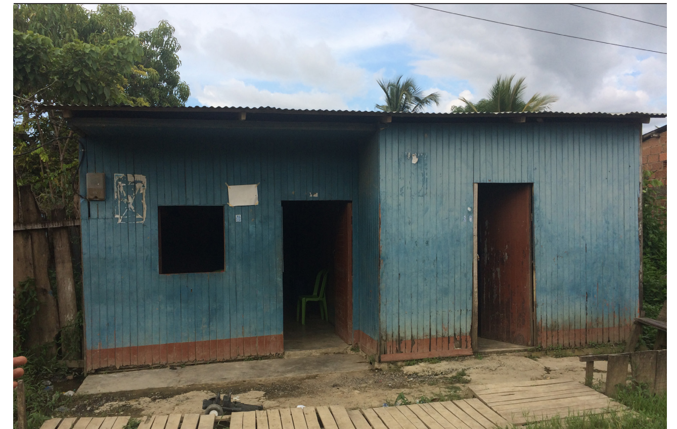
Figura 57 ▲ Materialidad vivienda tradicional. Fuente: Propia 2017.
