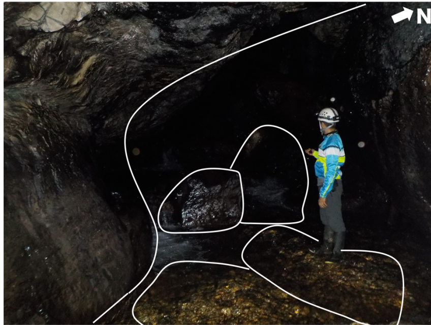
Figura 87. Cámara o vacío con ancho de a 3 metros aproximadamente.
