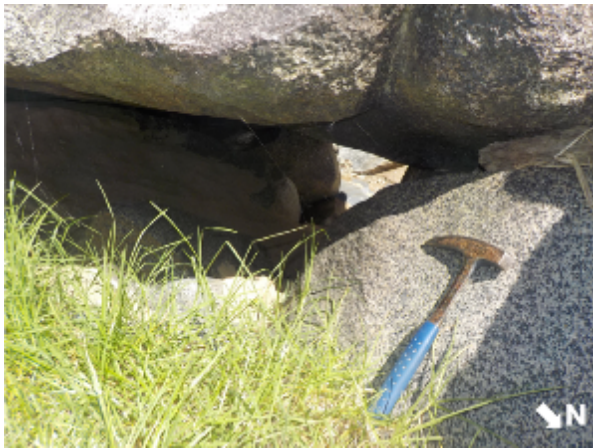
Figura 37. Cámara o vacío con aproximadamente 0,3 metros de altura.
