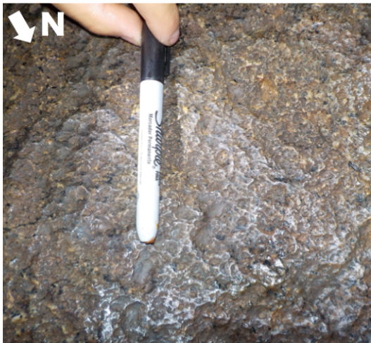
Figura 25. Bloque de roca con meteorización química de tipo oxidación.
