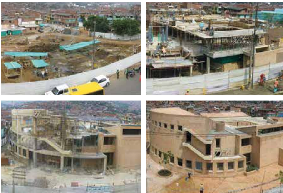
Figura 18. Proceso de construcción del Centro de Desarrollo Cultural de Moravia 2007
