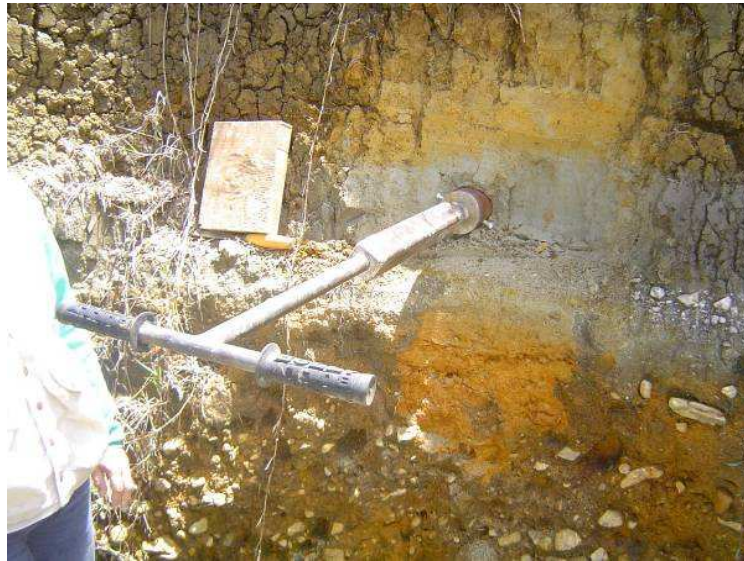
Figura 29. Tubo de acero introducido totalmente
