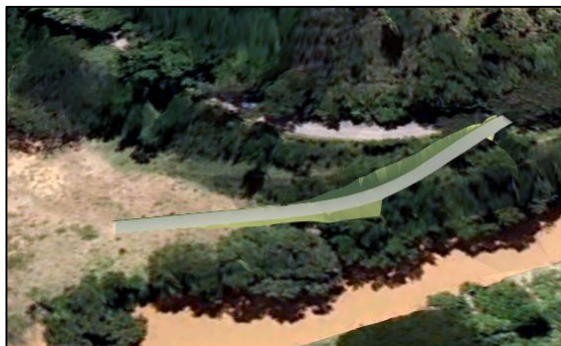
c) Vía de acceso al depósito 3
