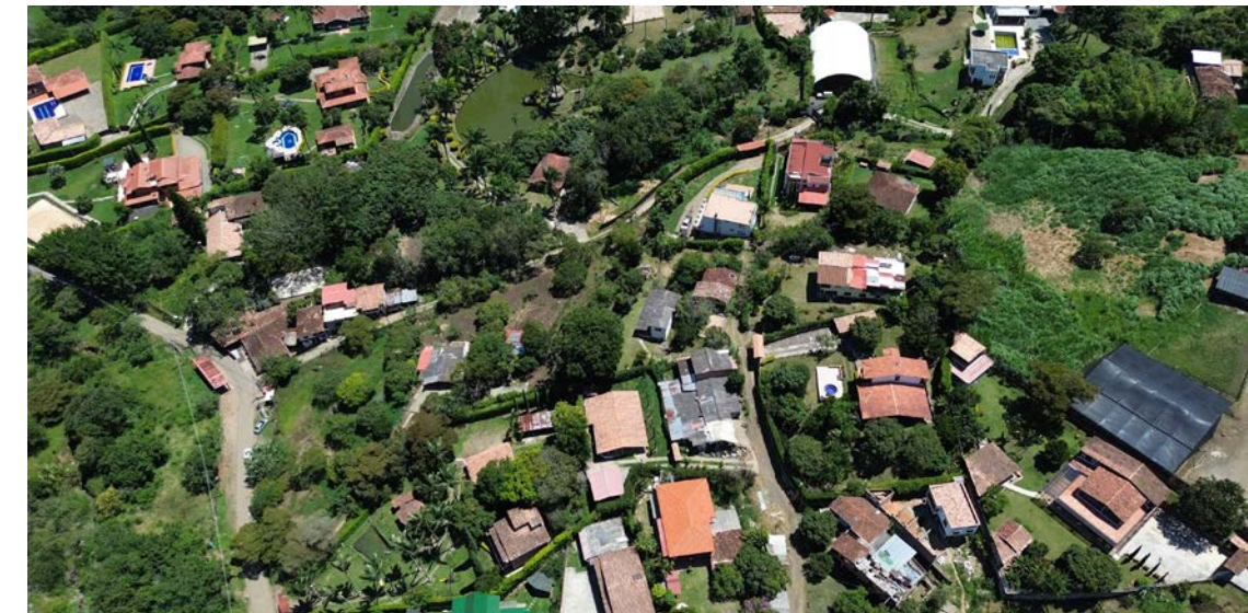
FIGURA 3: Vistas aéreas de la cuenca media en la que se evidencian los procesos de ocupación.
