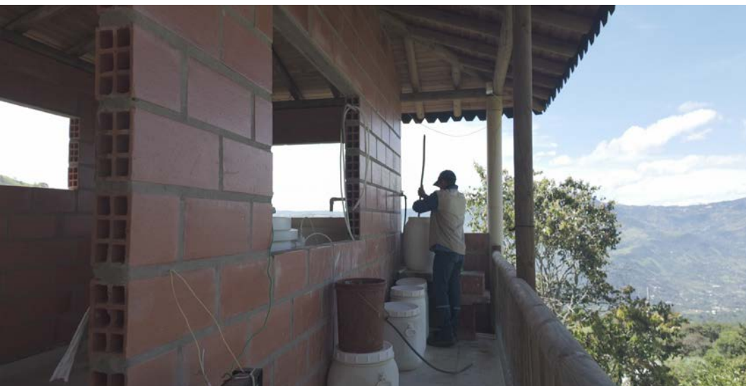
FIGURA 32: Operaciones en la infraestructura del acueducto comunitario AVEZA.
