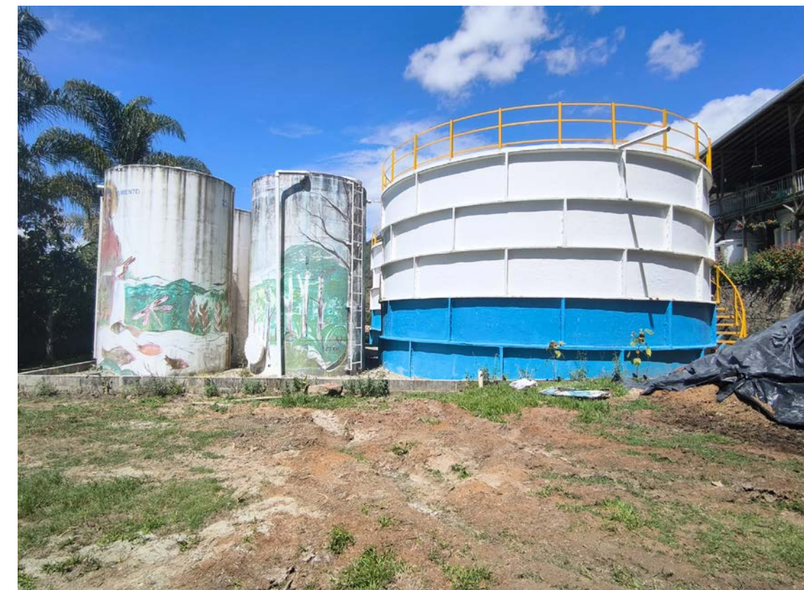
FIGURA 10: Acueducto veredal AVEZA. Tanques intervenidos gráficamente.
