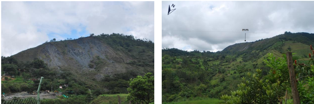
Ilustración 48 Deslizamiento rotacional en cercanías del casco urbano sobre las Ultramafitas de Angelópolis
