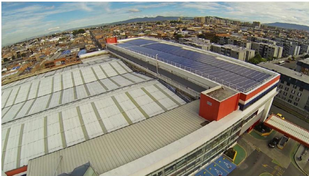
Figura 18. Ejemplo de paneles instalados en edificios.
