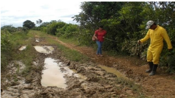
Figura 5. Vía Vereda Visinaca (2006)
