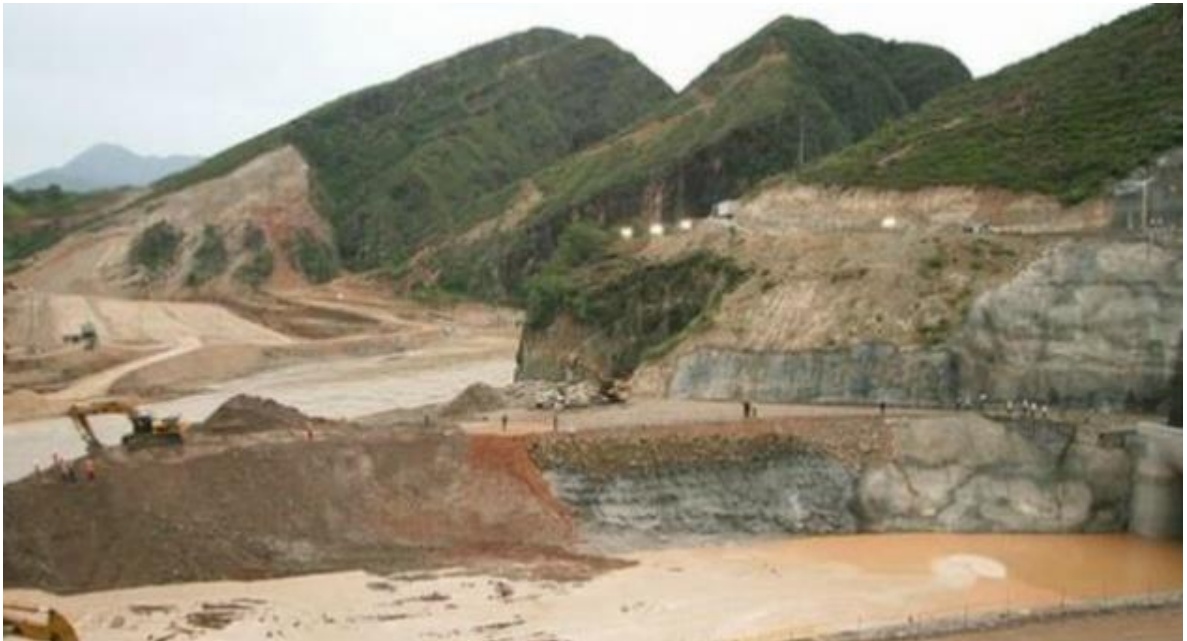
Hidroeléctrica el Quimbo – Huila, Colombia Fuente: http://www.rcnradio.com/2015/31/12
