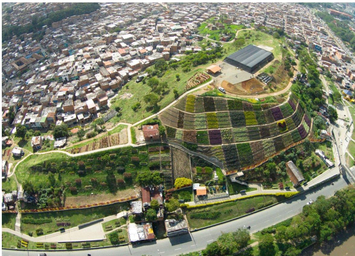
Imagen 53. Obras de jardinería.
