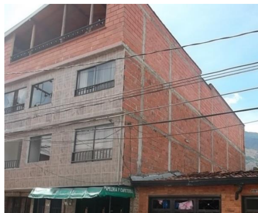
Figura 1.10. Edificación en muros de mampostería confinada
