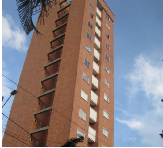
Figura 1.11. Edificación en pórticos de concreto reforzado
