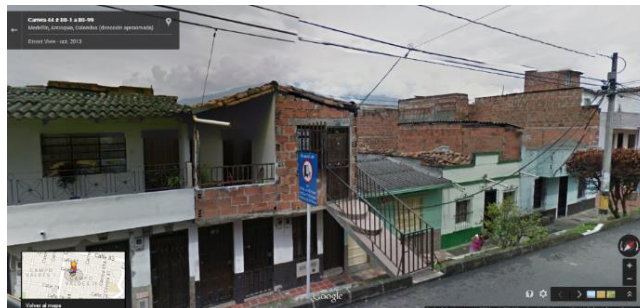
Figura 1.6. Construcciones presentes en el municipio de Medellín [17]
