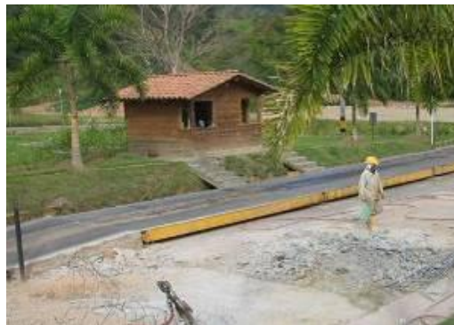
Ilustración 17 Caseta pesaje parque industrial La Pradera
