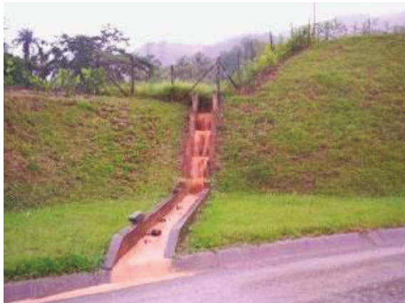
Ilustración 13 Sistemas de drenaje parque industrial La Pradera.
