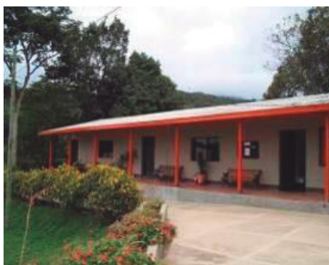
Ilustración 15 Escuela Reparada parque industrial La Pradera
