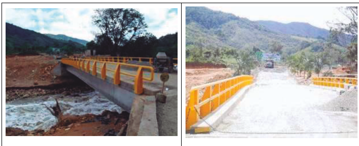
Ilustración 9 Puente de acceso parque industrial La Pradera
