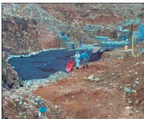
Ilustración 19 Adecuación Vaso la Carrilera
