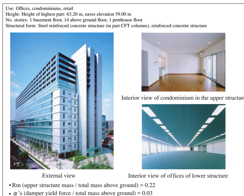
Fig 2. Vistas exterior e interior del edificio Idabashi First, First Hills Idabashi.
