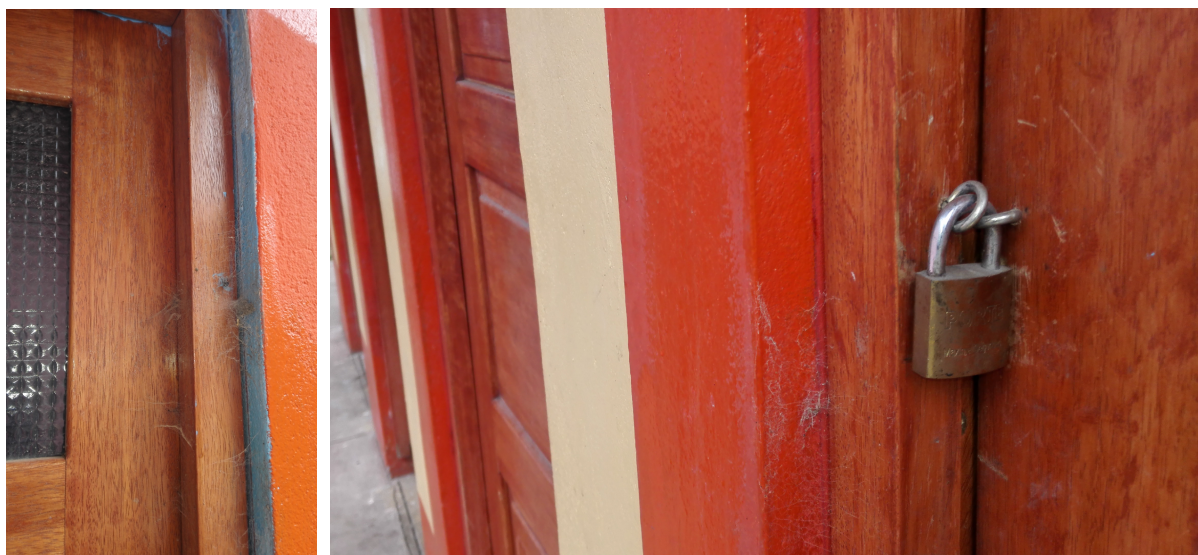
FUENTE: Servicios cerrados en la institución educativa de Escohorn - vista fotográfica propia.
