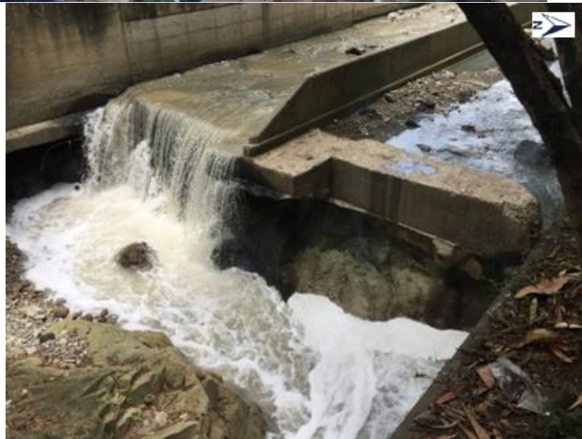
Figura 15. Azud a 120 metros de la carrera 80
