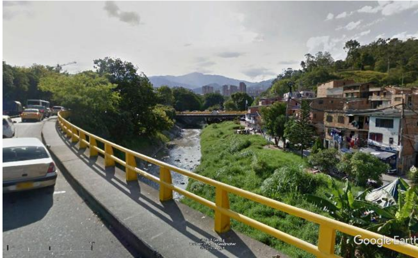
Figura 17. Obras de canalización aguas abajo de la Cra 80
