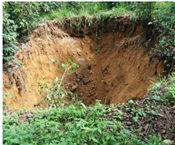
Ilustración 4. Subsidencia encontrada en el terreno aledaño al túnel Curazao
