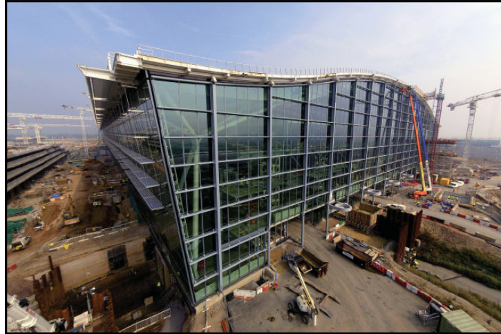
Imagen 1. Obra “Heathrow Terminal 5”
