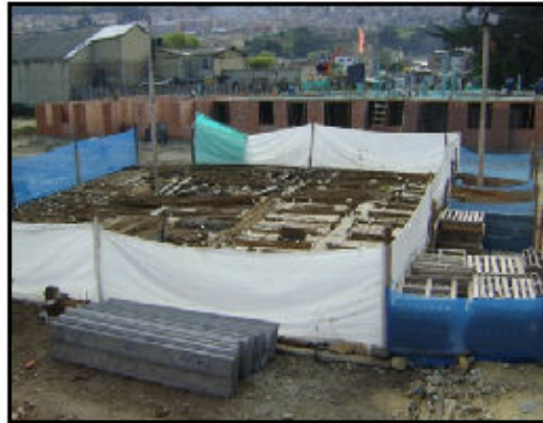
Imagen 10. Patio de clasificación de equipo de encofrado
