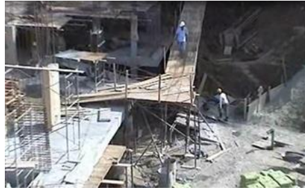
Figura 16: Revisión de proceso logístico y accesos a la estructura
