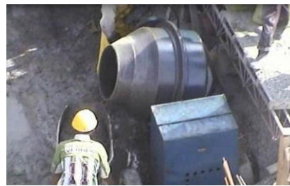
Figura 18: Seguimiento proceso dosificación
