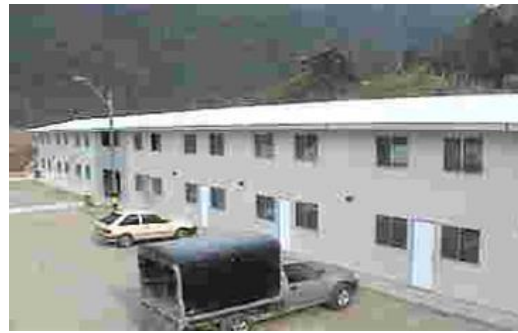
Figura 25: Seguimiento Hidroituango avance en los campamentos
