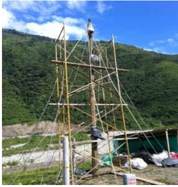
Figura 24: Montaje Hidroituango campamentos.
