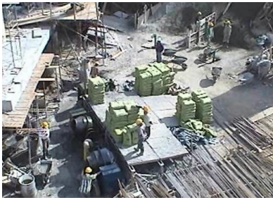
Figura 17: Seguimiento proceso dosificación concreto.
