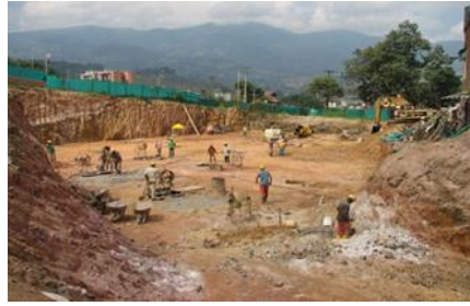
Figura 6: Monitoreo en excavaciones y pilas Torres Saltamontes (Monarca, 2011)
