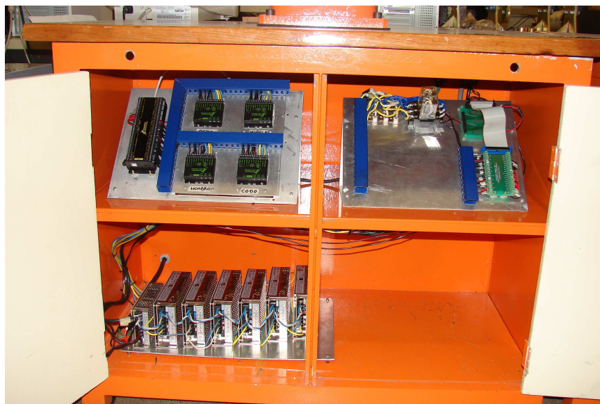
Ilustración 22. Montaje de los elementos del sistema de control
