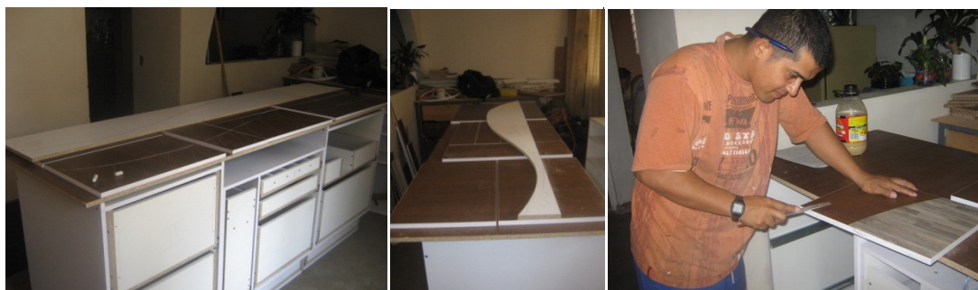
Figura 88. Corte y pegado de Fórmica.
