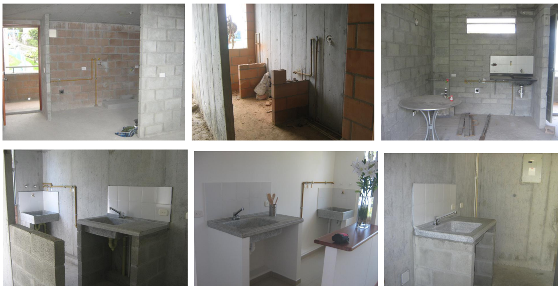
Figura 34. Espacio para construcción de muebles de cocina en vivienda de espacios reducidos.
