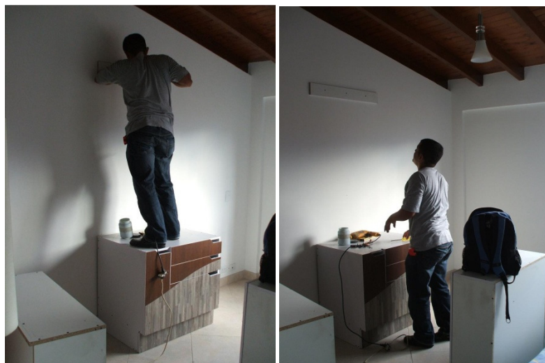
Figura 90. Instalación y montaje.
