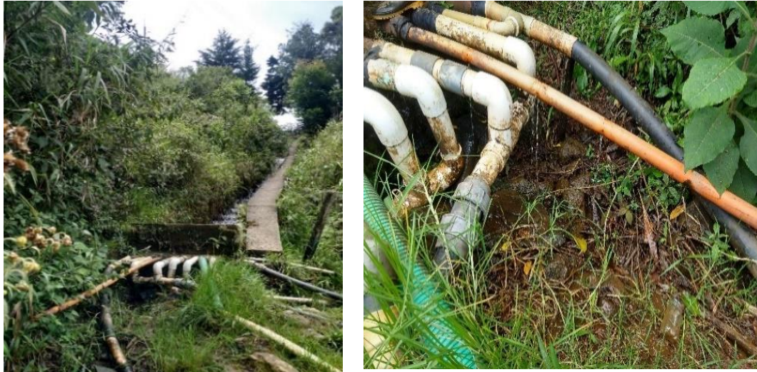
Figura 6-11. Bocatoma Tanque el Toldo, Bello Oriente.
