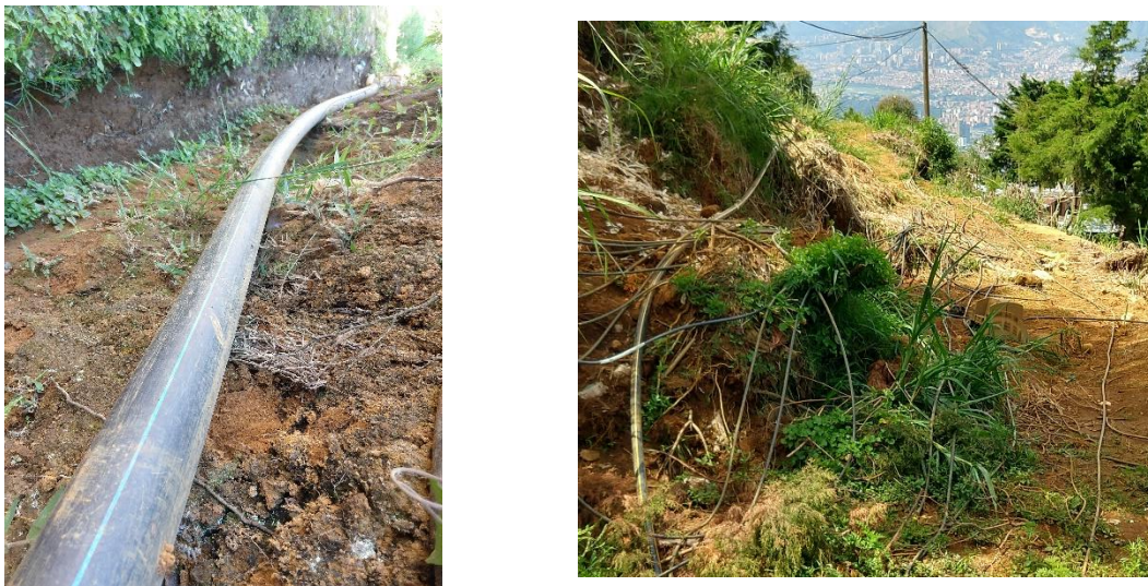
Figura 7-18. Distribución del agua captada del rebose del tanque El Toldo hacia las viviendas
