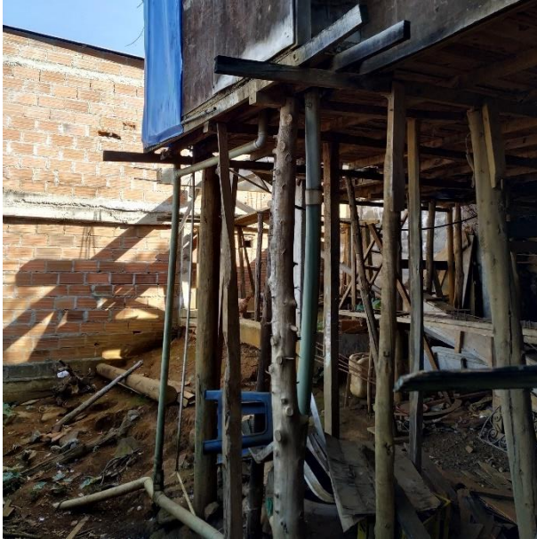
Figura 7-1. Fotografía métodos constructivos
