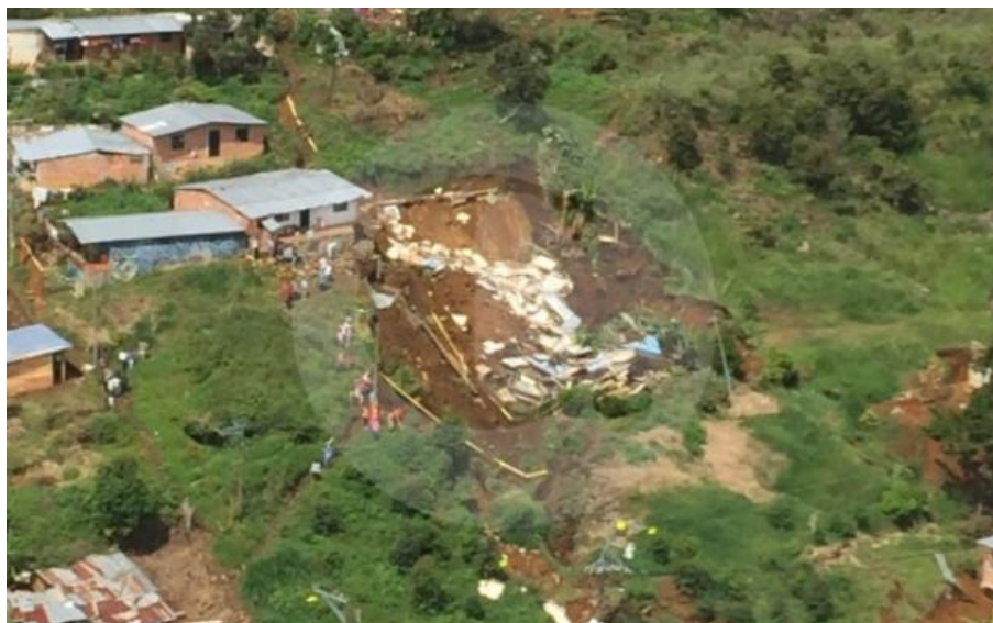
Figura 4-2. Deslizamiento en asentamientos de ladera – Barrio Oriente
