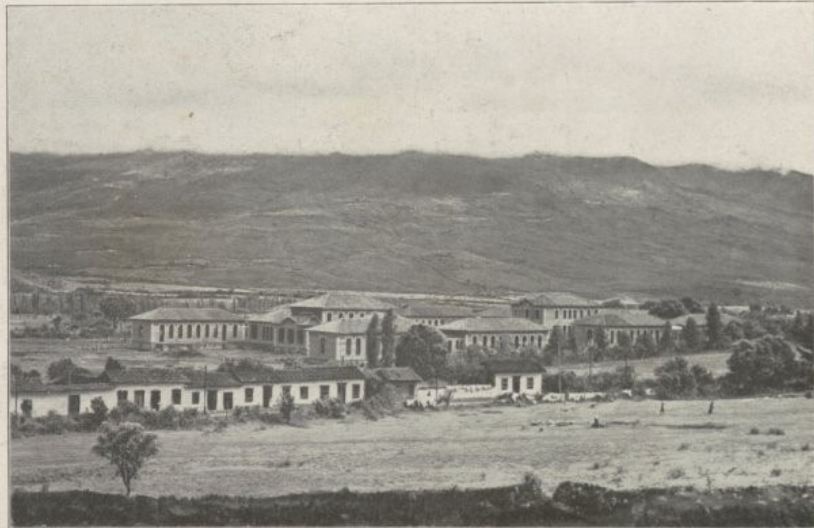
St. Vincent Hospital Krankenhaus St. Vicente de Paul
