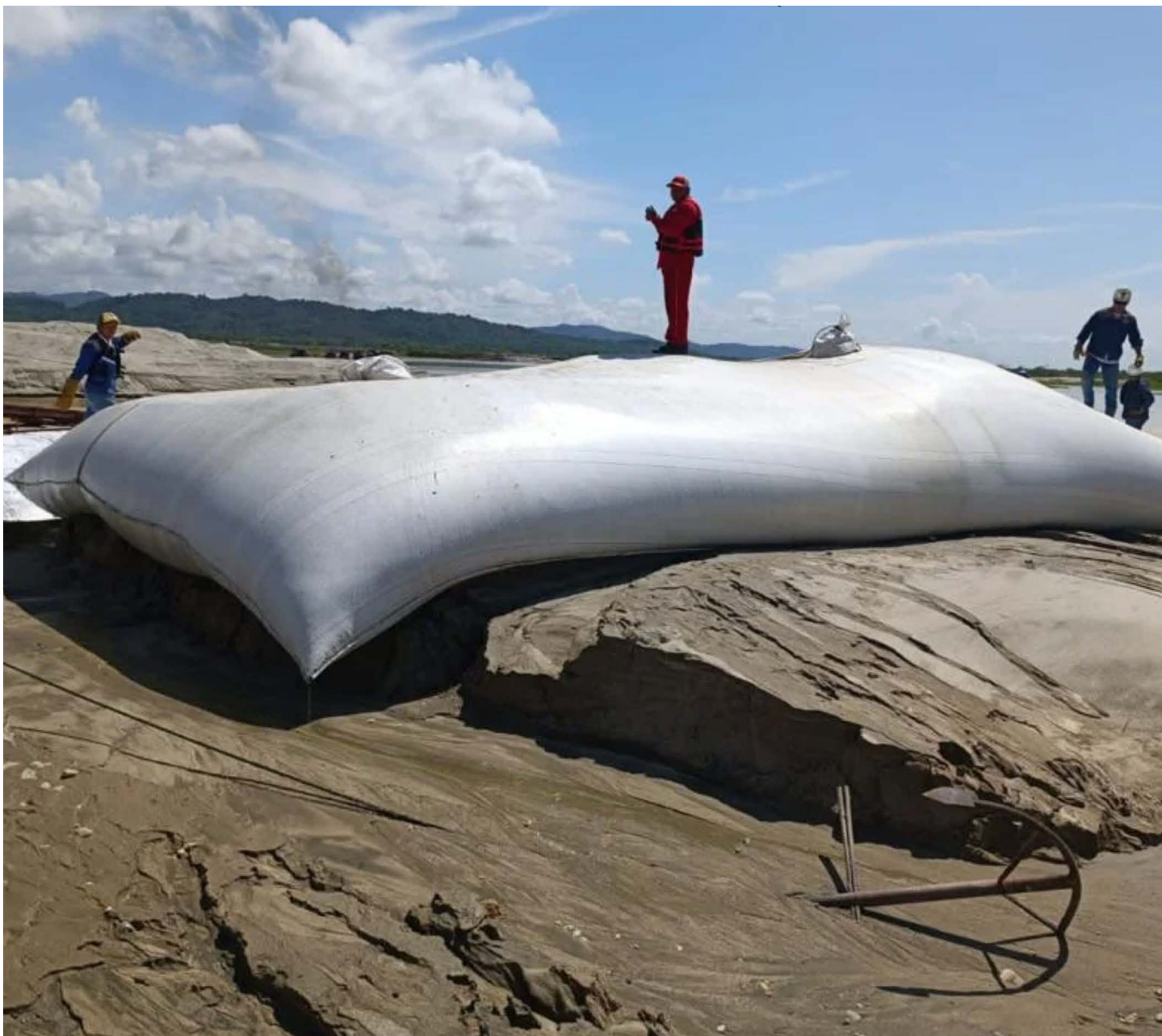
Geobolsa para la estabilización de Jarillones. Fuente: Esteban González P.
