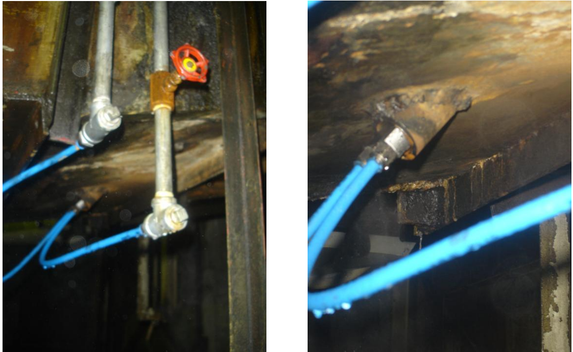
Figura 30. Montaje de las boquillas aspersores en el ducto del ventilador
