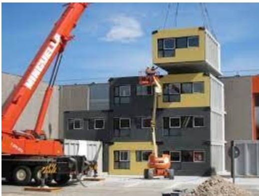
Figura 11 Sistemas de vivienda modular. Fuente: (De Arquitectura, 2023)
