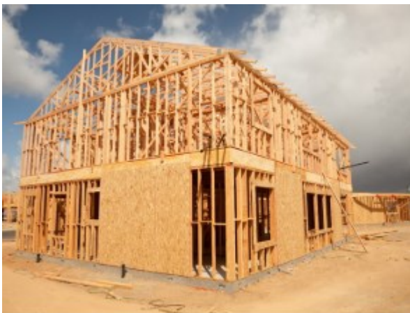
Figura 7 Vivienda unifamiliar ejecutada con el sistema Platform Frame
