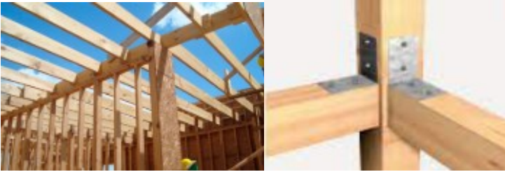
Figura 8 Estructura prefabricada de madera
