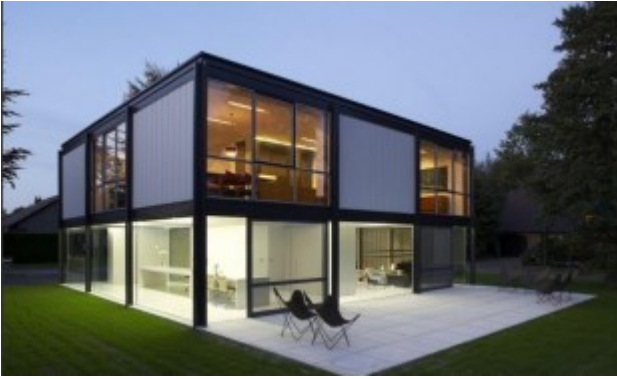
Figura 5 Casa Prefabricada de Acero. Fuente: (Crespo, 2022)
