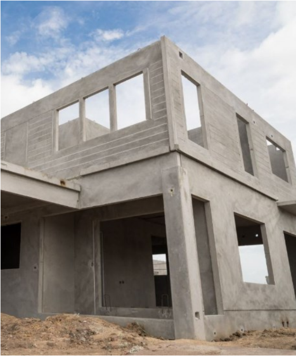
Figura 4 La Casa de Hormigón
