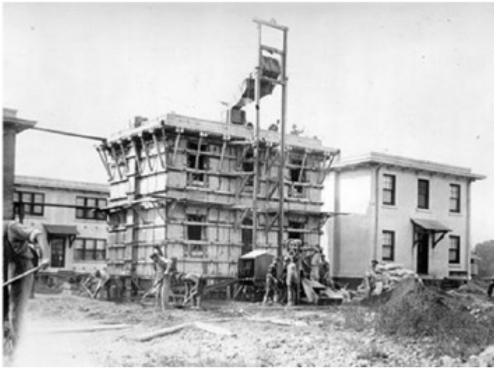
Figura 2 Modelo de casa de hormigón vertido, Thomas Edison, Unión, Nueva Jersey, 1908-1921. Fuente: (Bergdoll & Christensen, 2008)
