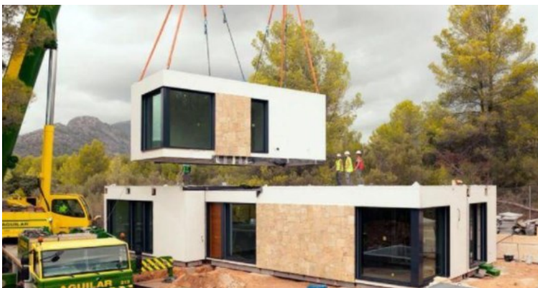
Figura 10 Construcciones modulares prefabricadas: Los diseños más modernos, (Inarquia, 2022).
