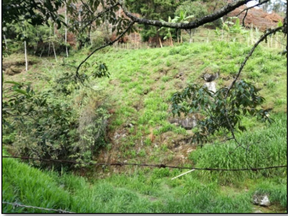
Foto 9. Depósito de Deslizamiento, localizado en la Qda. El Palo, cerca de su desembocadura en la Qda. La Ayurá.
