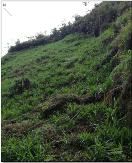
Foto 16. Deslizamiento Traslacional ubicado en la Quebrada El Palo.
