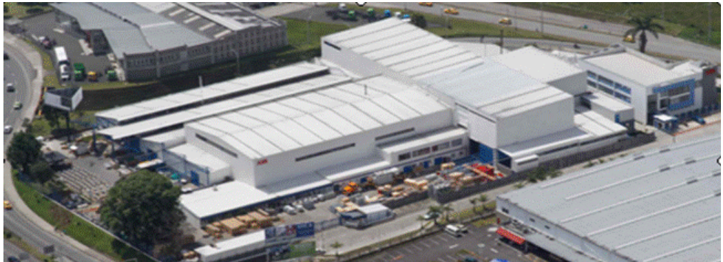
Ilustración 15. Imagen real de la fábrica de transformadores ABB Colombia.
