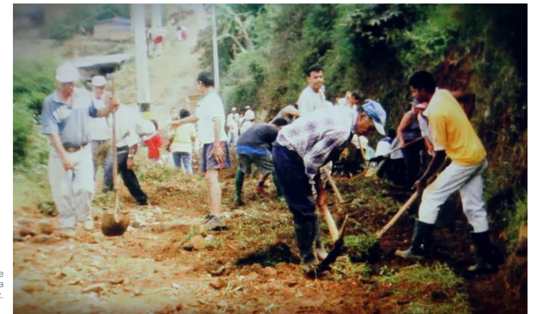
» Figura 14. Construcción de vías y servicios por parte de la comunidad del Barrio La Cruz. Tomado de EPM.
