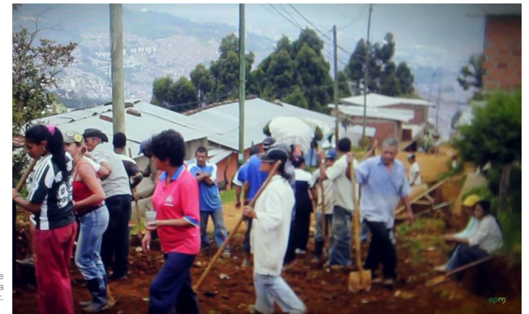
» Figura 15. Construcción de vías y servicios por parte de la comunidad del Barrio La Cruz. Tomado de EPM.
