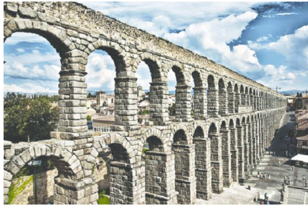
Fig. 1. Acueductos Romanos en Segovia, España.
