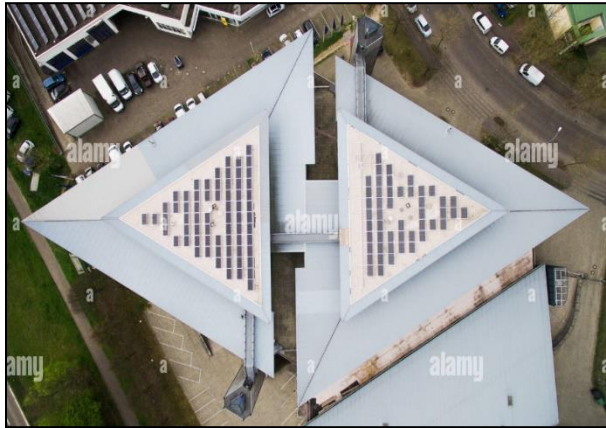
Fig. 50. Edificación conformada con irregularidad por ejes no paralelos.
