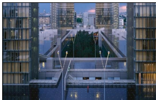
Fig. 43. Edificación con discontinuidad del sistema de piso en su paño central.
