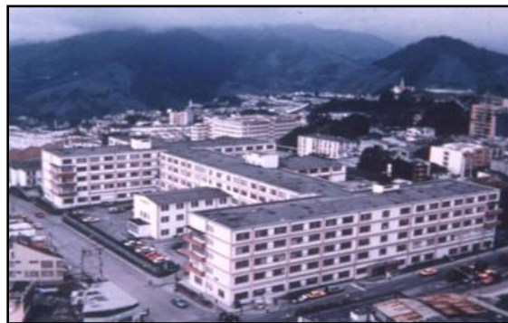
Fig. 45. Edificación con discontinuidad en el sistema de piso en los paños laterales.
