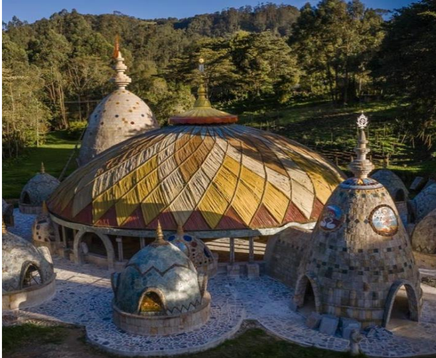
FIGURA 12. ESTRUCTURA DE SALÓN CULTURAL.
