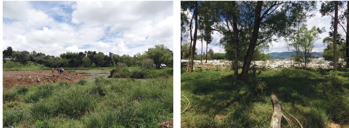
Llenado de humedales artificiales
