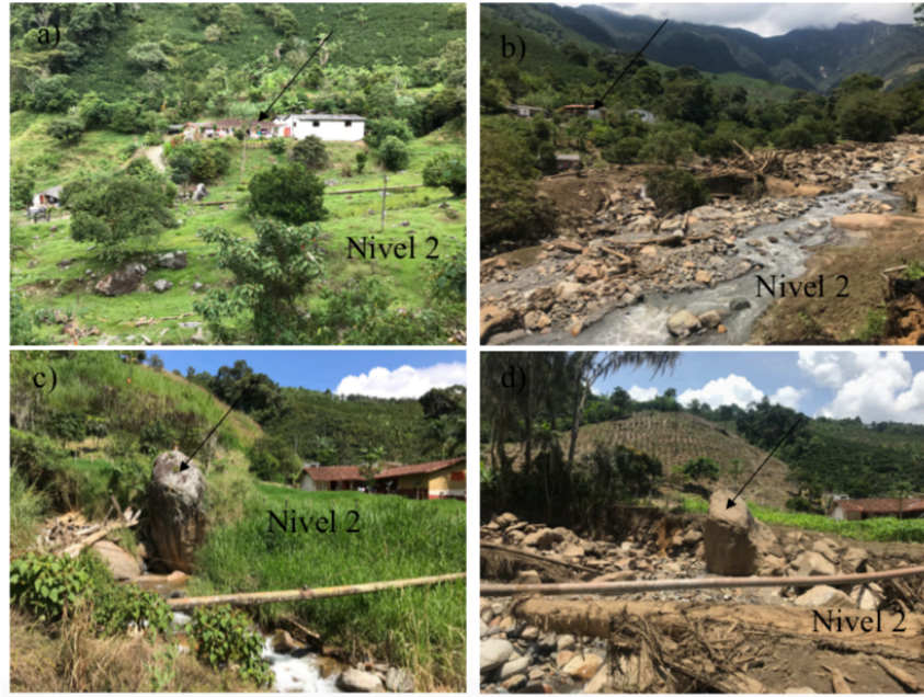
Figura 10. a) y c) Características de los niveles de carácter reciente antes de la avenida torrencial del año 2018 en la quebrada Los Monos. b) y d) Efectos de la avenida torrencial (E6) en la cuenca, en los mismos puntos referenciados en las fotografías a) y b).
