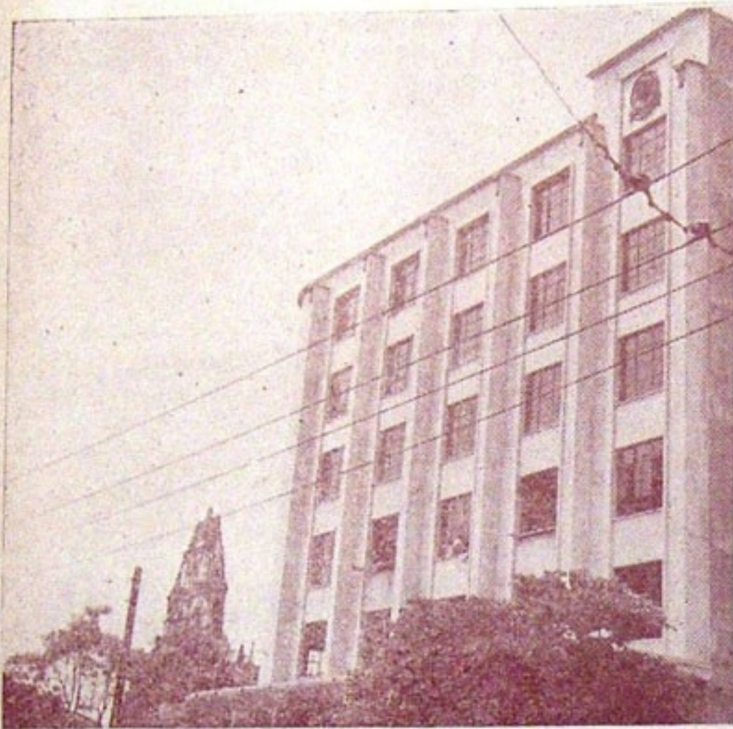
Bella fachada —aun inconclusa— del edificio que en Medellín construye la Cia. Colombiana de Seguros. Obras de esta clase pueden verse hoy por todas partes en la capital antioqueña que se halla en pleno crecimiento.
