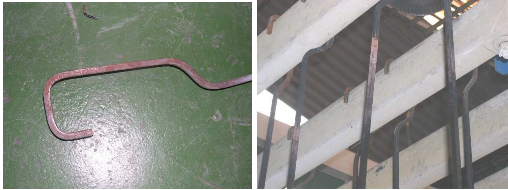
Figura 12. Gancho de unión al bastidor
