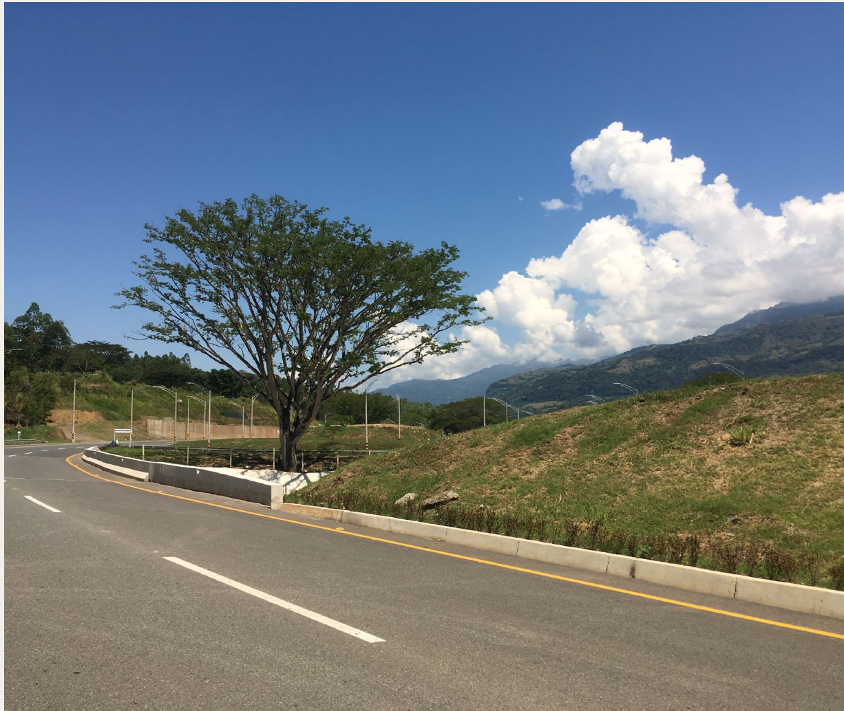
Fotografía 14 Conexión Pacífico 2, Támesis, Antioquia
