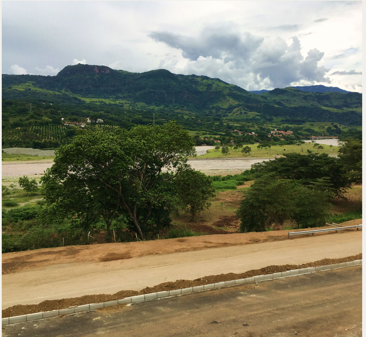
Fotografía 4 Construcción de la Conexión Pacífico 2, Valparaíso, Antioquia
