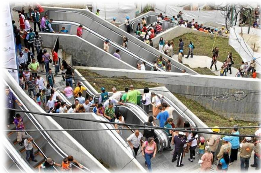
Imagen 4. Independencias I. Puesta en operación del sistema Escaleras Eléctricas
