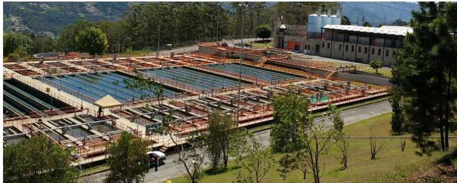
Ilustración 3 Planta de tratamiento de agua potable Manantiales. Medellín Antioquia. Fuente. (Autor, 2016)
