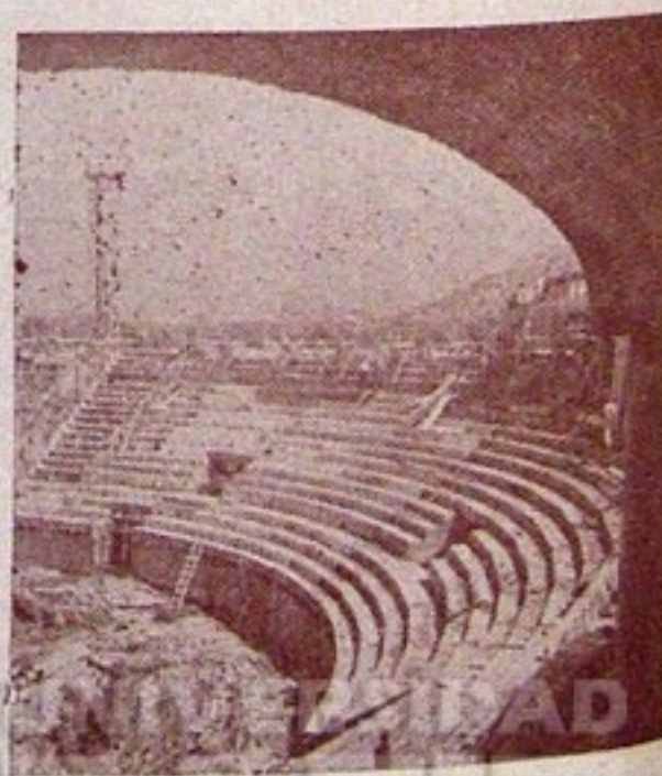
Aspecto que presenta uno de los tendidos recientemente vaciados. Los trabajos marchan aceleradamente.
