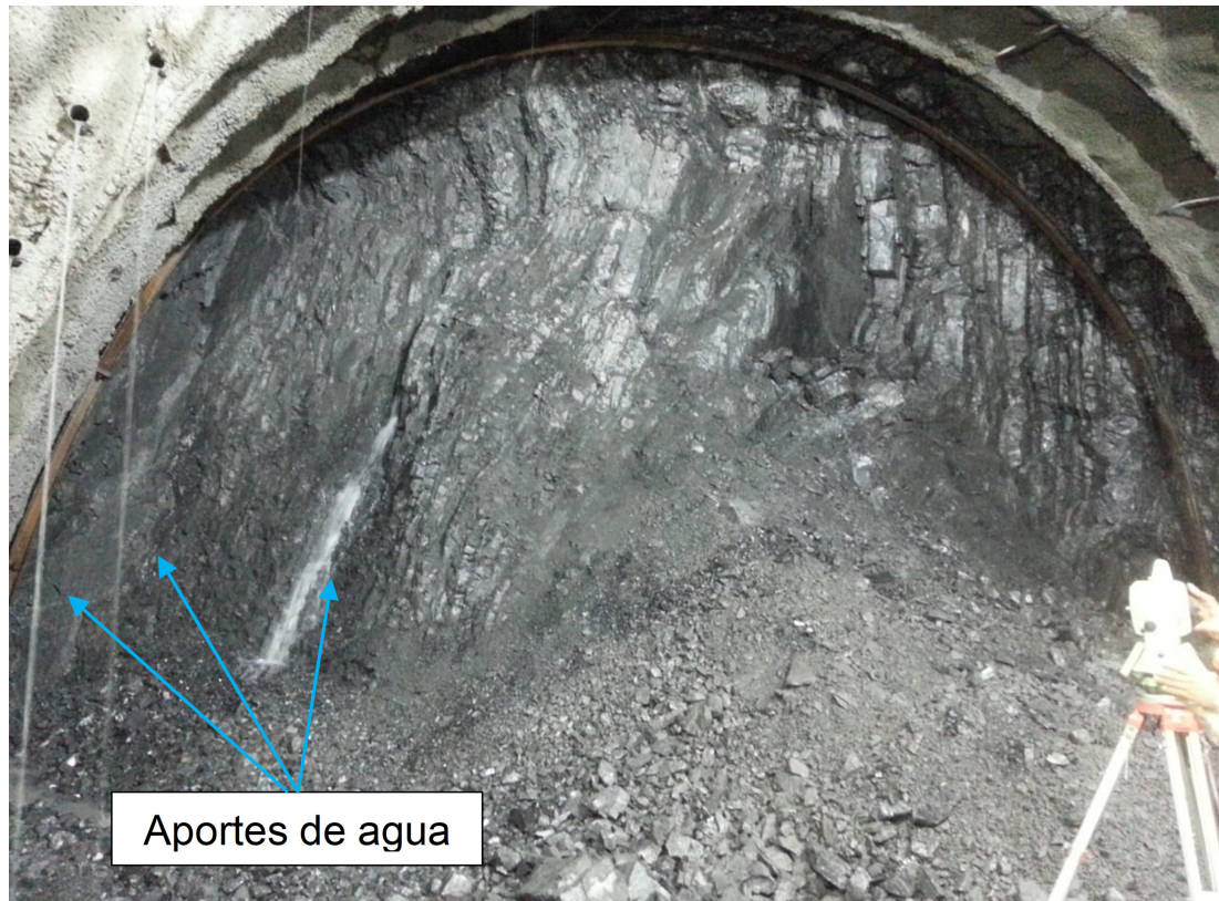
Figura 3.3.2: Macizo rocoso excavado en el Túnel GGE, km 35+092,25, Elaboración Propia
