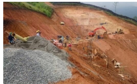
Foto 6. Obra constructora G, vivienda. Archivo propio
