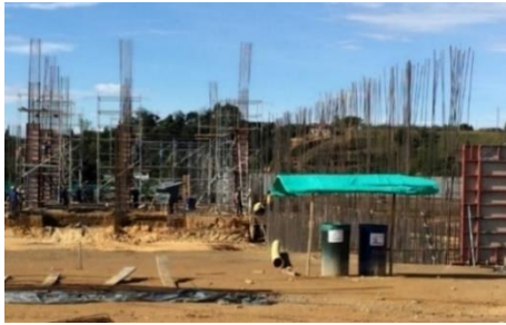
Foto 1. Obra constructora A, oficinas. Archivo propio
