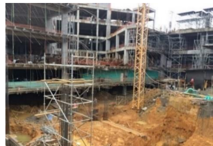
Foto 4. Obra constructora D, vivienda-comercio. Archivo propio
