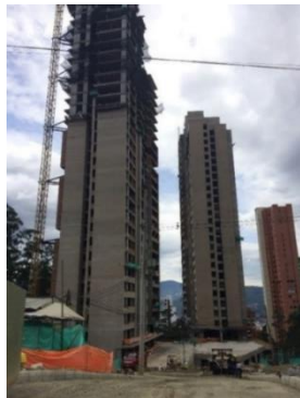
Foto 3. Obra constructora C, vivienda. Archivo propio
