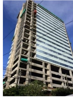
Foto 2. Obra constructora B, oficinas. Archivo propio
