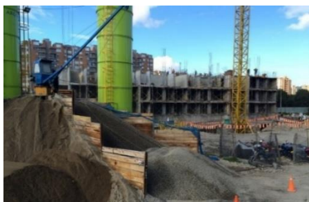
Foto 7. Obra constructora I, vivienda. Archivo propio
